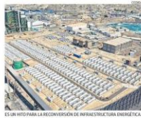
ES UN FOTO PARA LA RECONVERSIÓN DE INFRAESTRUCTURA ENERGÉTICA.
