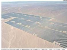
BESS COYA PERMITE SUMINISTRAR ENERGÍA VERDE A 100 MIL HOGARES.
