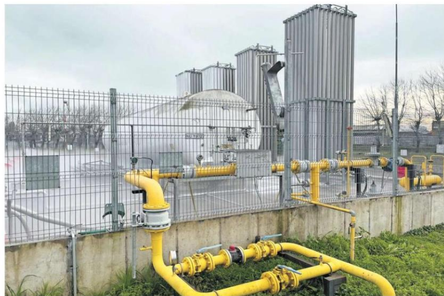
La Planta Satélite Regasificadora se encuentra dentro del complejo de la empresa Nestlé, en Los Angeles.
