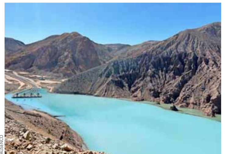
Sistema de recuperación de agua en tranque de relaves.
